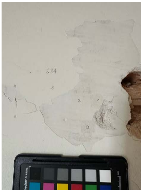
Abb. 82: Sondierung oberer Wandabschnitt. Glatte Putz mit weissen Anstrichen.
