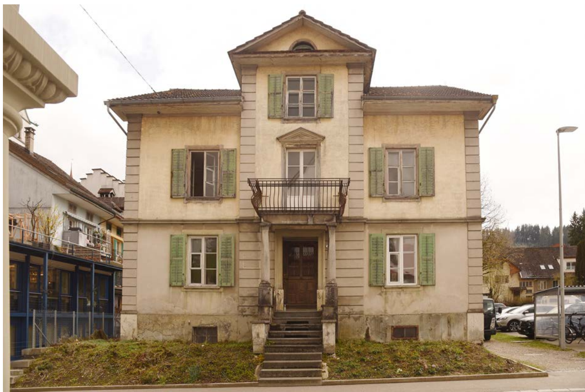
Nordfassade von der Heilig-Blut-Kapelle her fotografiert, Zustand März 2026.
