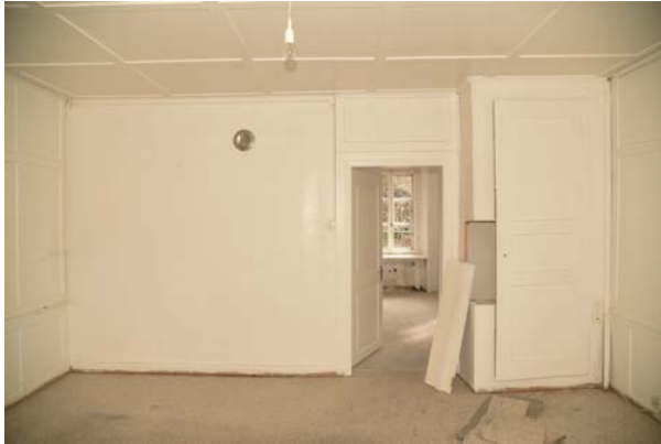
Abb. 73: Südwand/Ofenwand. Links der Tür stand baueitlich ein Ofen.
