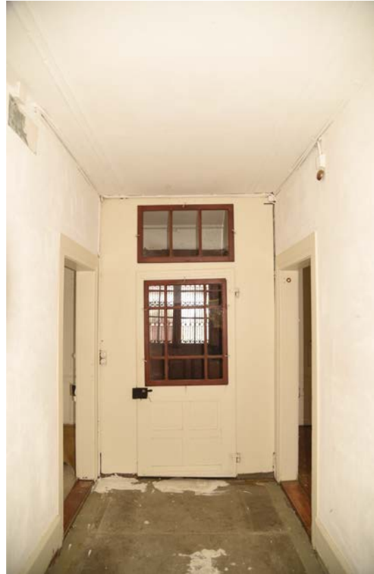
Abb. 61: Blick nach Nord: Korridor mit Windfang. Bauzeitlicher Sandsteinboden und Stuckdecke.
