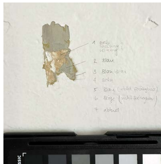
Abb. 75: Sondierung der verputzten Südwand: 6 Farbfassungen. Älteste in gelblich-Beige.
