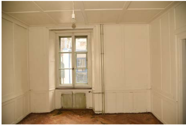
Abb. 70: Ostwand mit bauzeitlichem Fenster.
