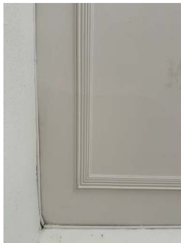
Abb. 45: Korridor. Deckenstuck. Bauzeitlich.
