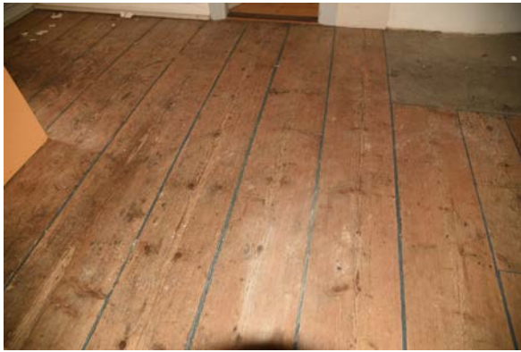
Abb. 117: Einfacher Riemenboden aus der Bauzeit.
