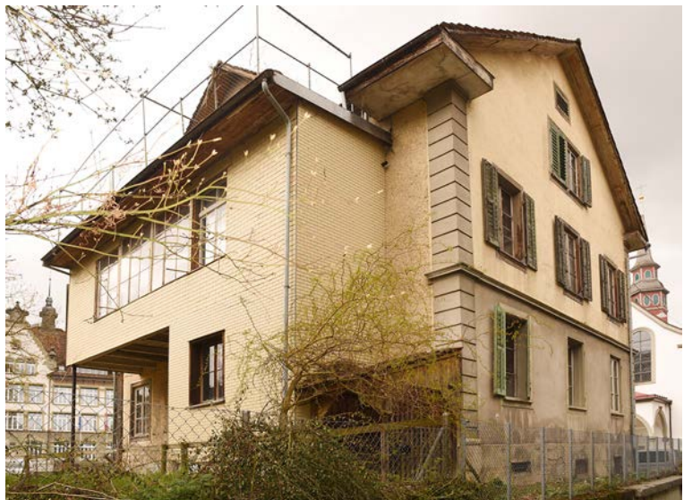
Abb. 4: Ansicht von Südosten. Rechts die Ostfassade mit verputzter Ecklisene in der Art der Nordseite gestaltet, links grob verputzte Süd-fassade mit Laube.
