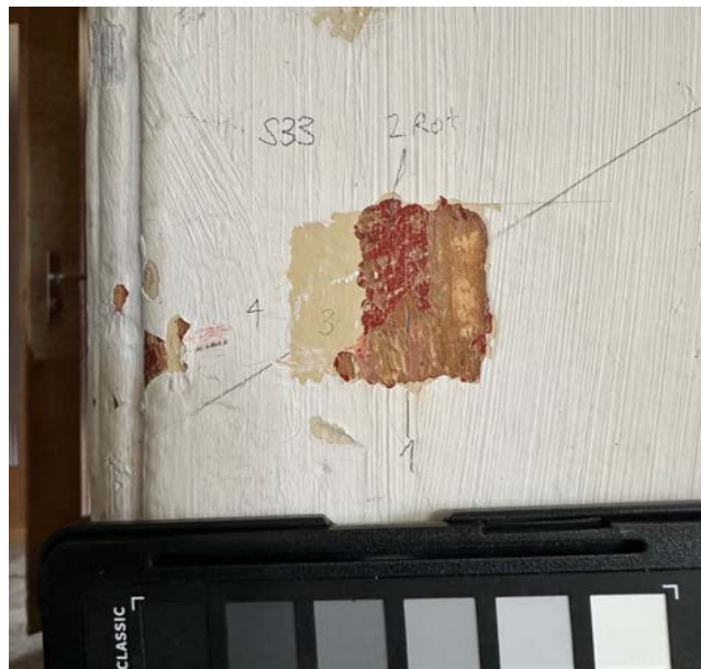
Abb. 83: Sondierung Türrahmen. 4 Fassungen. Älteste in Braun/Ocker.
