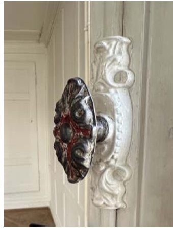
Abb. 43: EG. Handolive. Bauzeitlich.
