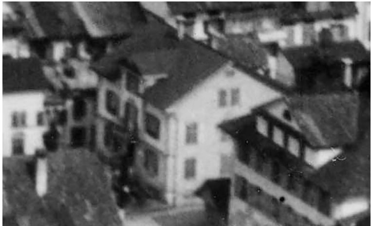
Abb. 27: Um 1960 datierte Flugaufnahme. Zustand mit abgesetztem Sockel an der Nordfassade. Stadtarchiv Willisau.
