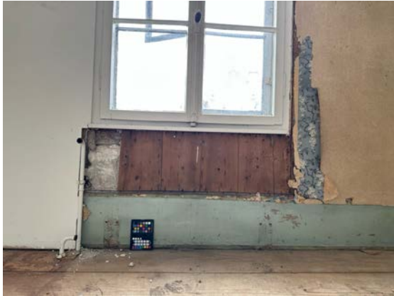
Abb. 108: Sondieröffnung Westwand. Bauzeitliche Lambrie.
