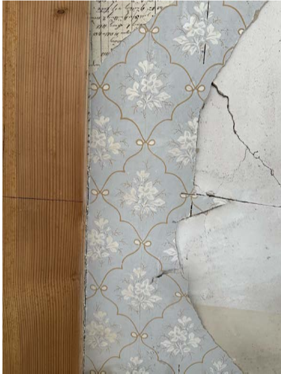
Abb. 92: älteste Tapete, direkt auf den Putz geklebt. Darüber Bretterwand (linker Bildrand).
