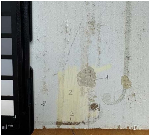
Abb. 120: Sondierung Täferfüllung, hinter ausgebautem Heizkörper. 1=älteste Fassung Grau. 2=Gelb mit Schnörkeln im Eck. 3 = Weiss.
