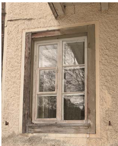
Abb. 18: Erhaltener Besenwurf-Verputz der Phase 3 an der Südfassade mit glattem Rand um die Fenstereinfassung.
