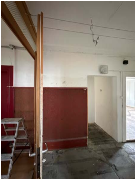
Abb. 80: Korridor Westwand. Rupfenbespannung jünger.
