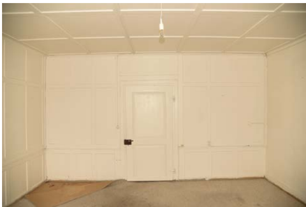
Abb. 74: Ostwand. Bauzeitliche Tür und Knetäfer. Das Täfer darüber und die Decke gehören zur zweiten Gestaltungsphase.
