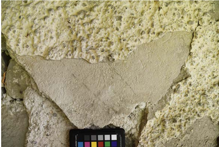
Abb. 9: Befund des bauzeitlichen Verputzes unter dem Unterstand (Südfassade, Abb. 10). Der Putzaufbau ist an dieser Stelle wie folgt:
