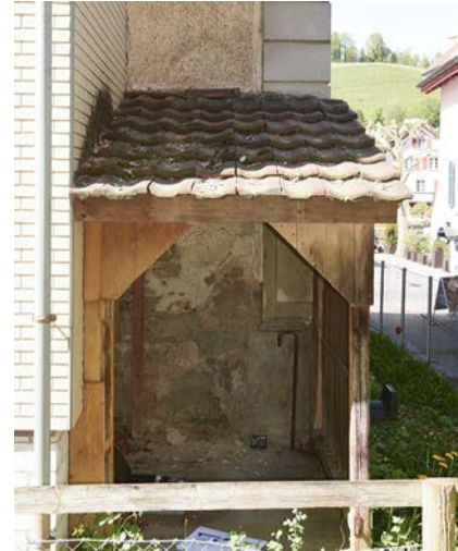
Abb. 10: Gedeckter Unterstand an der südöstlichen Hausecke. Über dem Dach die verputzten Ecklisenen der Phase 1922, darunter ist die hölzerne Lisene aus der Bauzeit erhalten. Somit ist der Unterstand älter als 1922.
