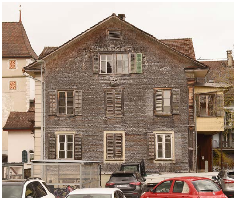
Abb. 5: Westfassade mit Schindelrand.
