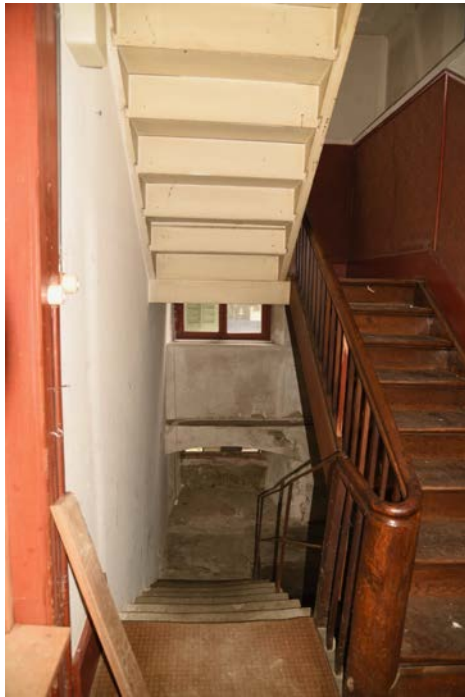
Abb. 50: Treppenhaus. Abgang ins UG. Aufgang zum 1. OG.
