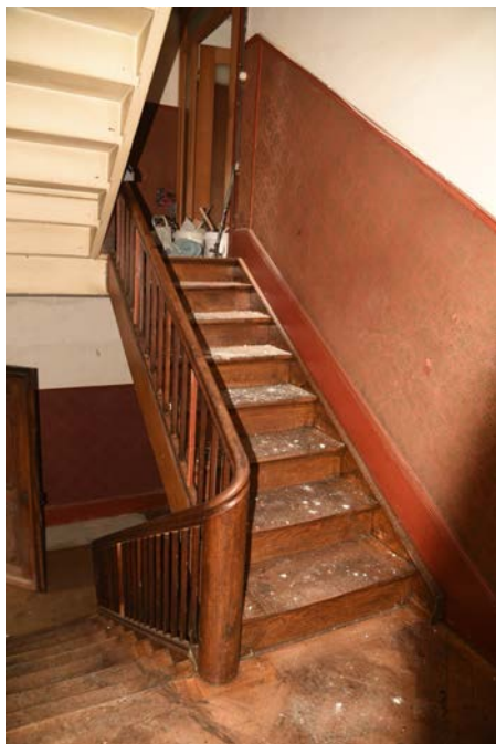
Abb. 51: Treppenhaus. Abschnitt EG nach 1. OG. Wand mit Rupfen.
