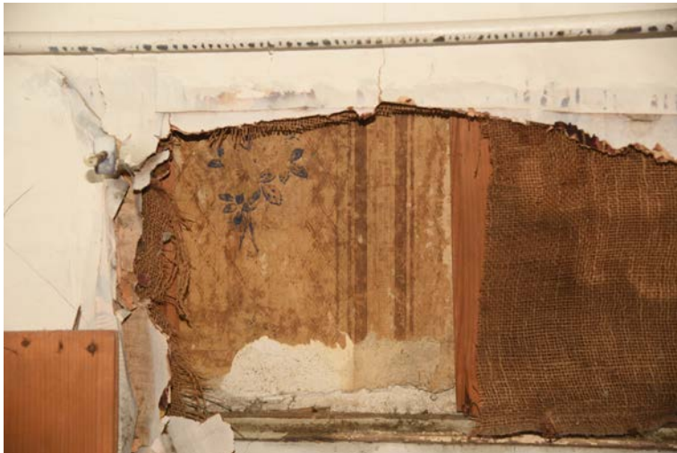
Abb. 88: Reste einer bauzeitlichen Tapete unterhalb Fenster. Rechter Bildrand: grobe Jute auf Bretterwand der zweiten Gestaltungsphase.
