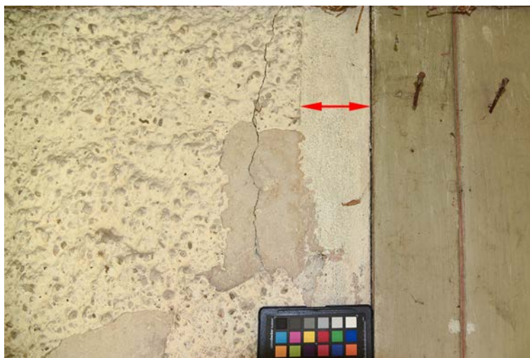
Abb. 19: Befund unter dem gedeckten Unterstand auf der Südseite (vergl. Abb. 10). Grobkörniger Besenwurf der Phase 3 mit 8 cm breitem, glatt verputztem Rand entlang der Lisene (roter Doppelpfeil).
