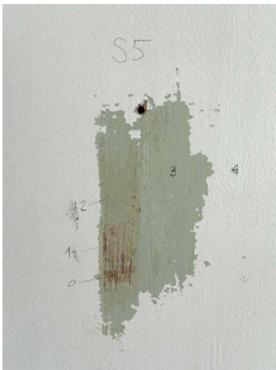
Abb. 69: Sondierung an Türblatt (Tür zu Raum 0.2). Älteste Fassung blau/grau (Nr. 1).
