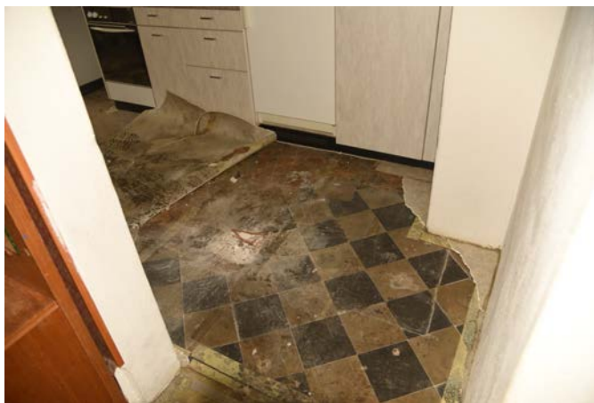
Abb. 113: Küche. Bauzeitlicher Fliesenboden, Schachbrettmuster.
