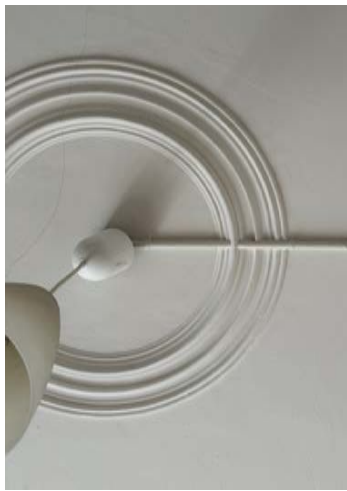
Abb. 44: 1. OG. Stuckring. Zimmerdecke. Bauzeitlich.
