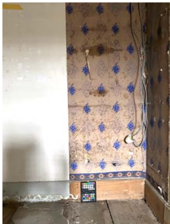
Abb. 33: DG. Bauzeitliche Wandgestaltung mit Lambrie und Tapete, dazu Riemenboden.
