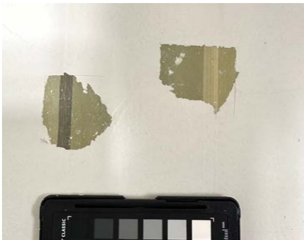
Abb. 76: Ostwand. Sondierung auf die drittälteste Fassung. Das heutig sichtbare Täfer ist hier auf Putz aufgemalt (helle und dunkle Filets imitieren den Täferrahmen).
