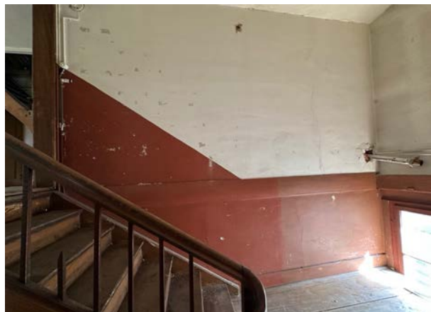
Abb. 54: Treppenhaus, zwischen 1. OG und DG. Glatt verputzte Wand, aufgemalter Sockel in Rot.
