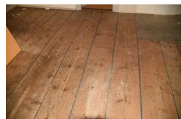
Abb. 49: DG. Riemenboden. Bauzeitlich.
