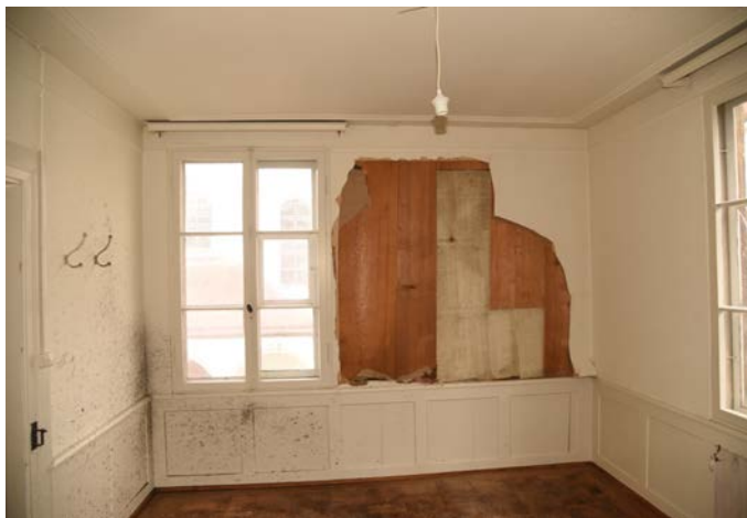
Abb. 91: Nordwand mit Sondieröffnung. Bretter oberhalb Knie-täfer wurden später hinzugefügt. Darunter ältere Tapete.
