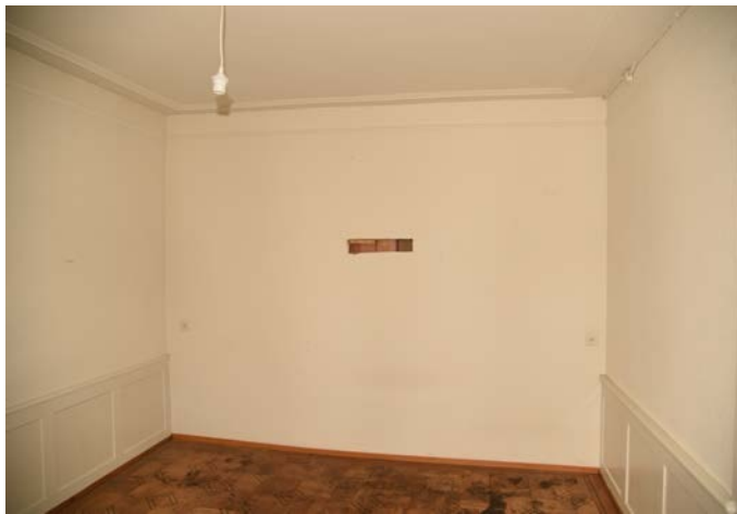
Abb. 90: Ansicht Süd. Zugemauerte Türöffnung zu Raum 1.2.
