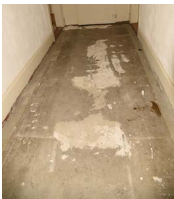
Abb. 46: EG. Sandsteinplattenboden, bauzeitlich.
