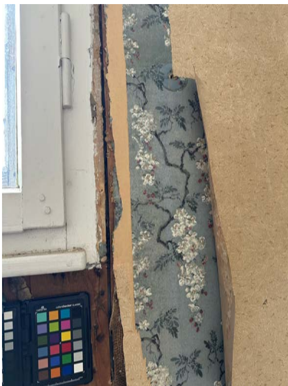
Abb. 109: Sondieröffnung Westwand. Bretterwand (zweite Gestaltungsphase) mit Jute, Zeitungsschicht und div. Lagen Tapeten.
