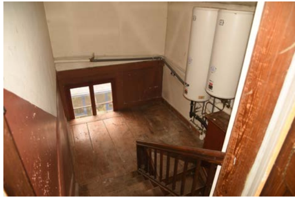
Abb. 53: Treppenhaus. Zwischenpodest zwischen 1. OG und DG. Einfacher Riemenboden.
