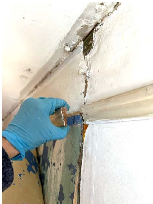
Abb. 67: Übergang Wand zu Decke. Unter der Profilleiste ist die älteste blaue Tapete erhalten (Blauer Grund, vertikale braune Kordel alle 10cm). Darüber folgt ein hellblauer Anstrich (2. Gestaltungsphase).
