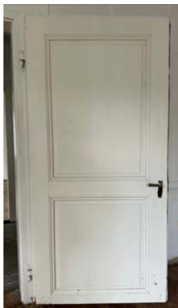
Abb. 39: EG. Standardtür, bauzeitlich.
