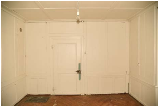
Abb. 71: Westwand mit bauzeitlicher Tür. Links befand sich ein Ofen in der SW-Ecke.
