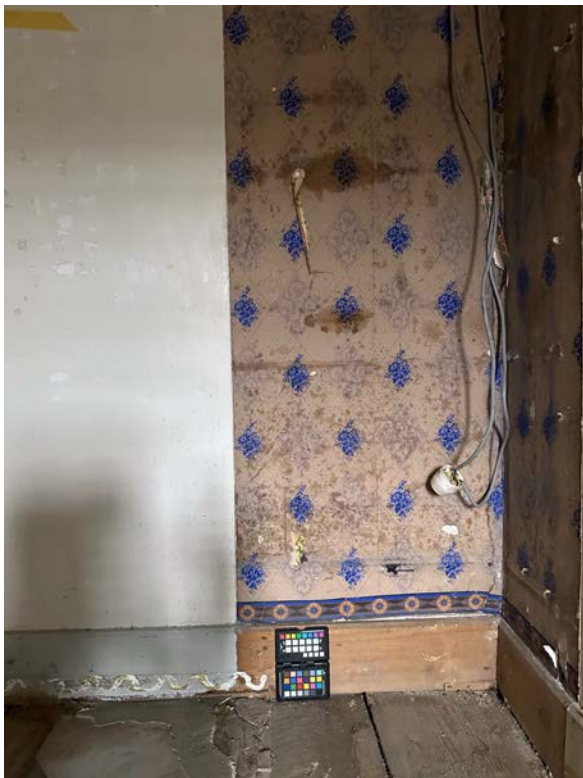
Abb. 118: Raum 2.2. Bauzeitliche Tapete mit holzsichtiger Lambrie hat sich hinter ausgebautem Schrank erhalten.
