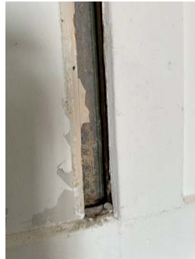
Abb. 100: Sondieröffnung Südwand. Unter dem Täfer findet sich eine Tapete. Wohl bauzeitliche Gestaltung.
