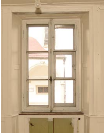
Abb. 42: EG. Standard-Doppel-fenster mit Handolive, bauzeitlich.
