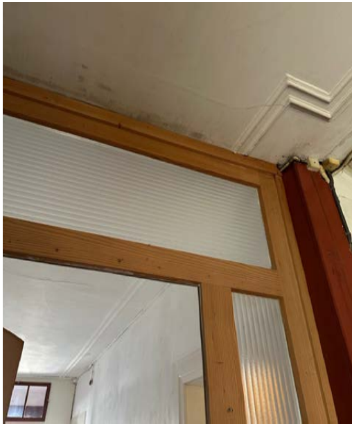
Abb. 52: Treppenhaus/Korridor EG. Stuckprofil Decke läuft unter Windfang durch.
