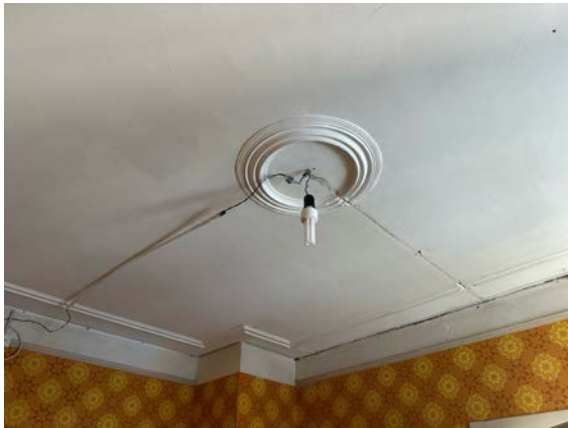
Abb. 66: Bauzeitliche Decke mit stuckierten Profilen.
