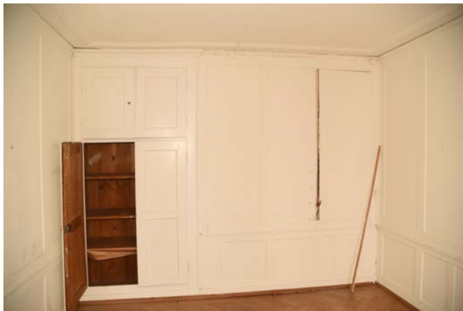
Abb. 98: Südwand mit bauzeitlichem Wandschrank.
