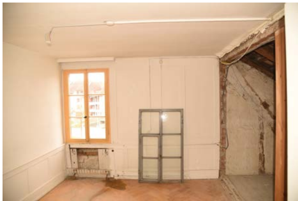
Abb. 121: Ansicht West. Bauzeitliches Knetäfer später raumhoch ergänzt.
