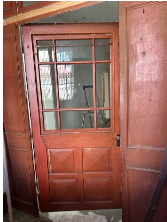
Abb. 63: Aussenseite Windfangtür Nord.
