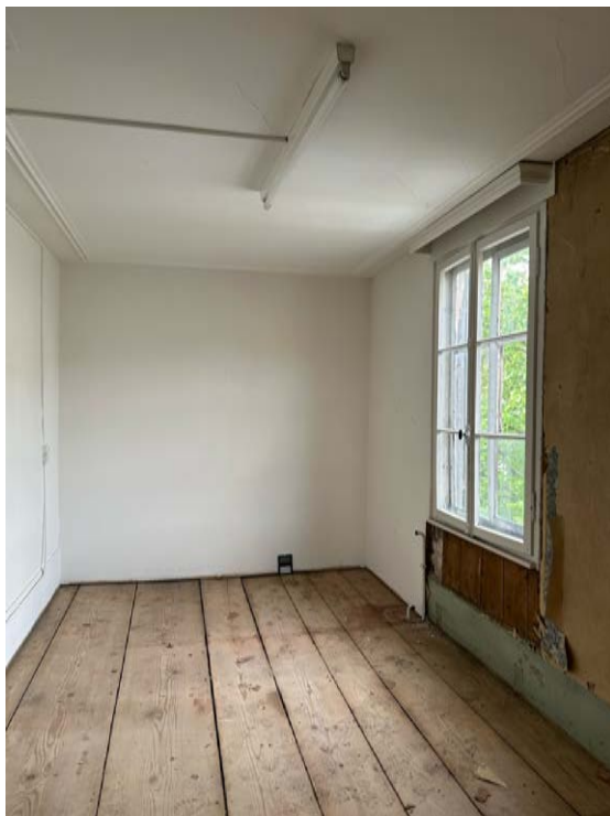
Abb. 107: Blick gegen Süd. Bauzeitlicher Bretterboden.
