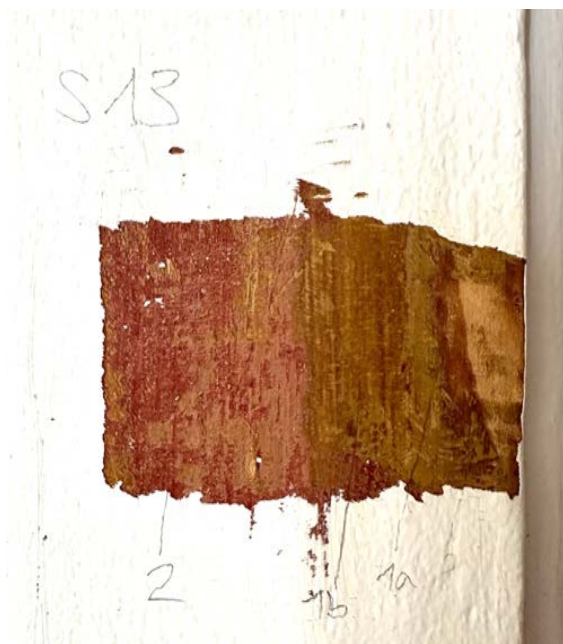
Abb. 58: Sondierung an Türgewand (Tür zu Raum 0.3). 1a = hellbrauner Grund für Maserierung. 1b = Dunkelbraune Maserierung (älteste Gestaltung). 2 = rote Fassung. 3 = aktuelle, weisse Fassung.
