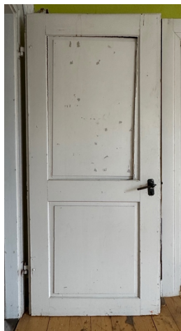
Abb. 36: DG. Standardtür mit Klinke/Schild, bauzeitlich.
