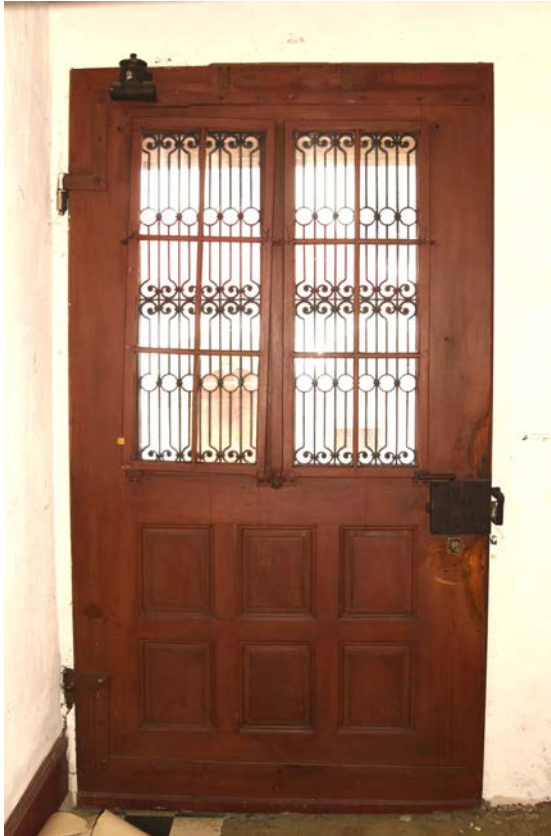
Abb. 60: Haustür Nord, bauzeitlich, ev. Elemente davon ertüchtigt (Anf. 20. Jh.).
