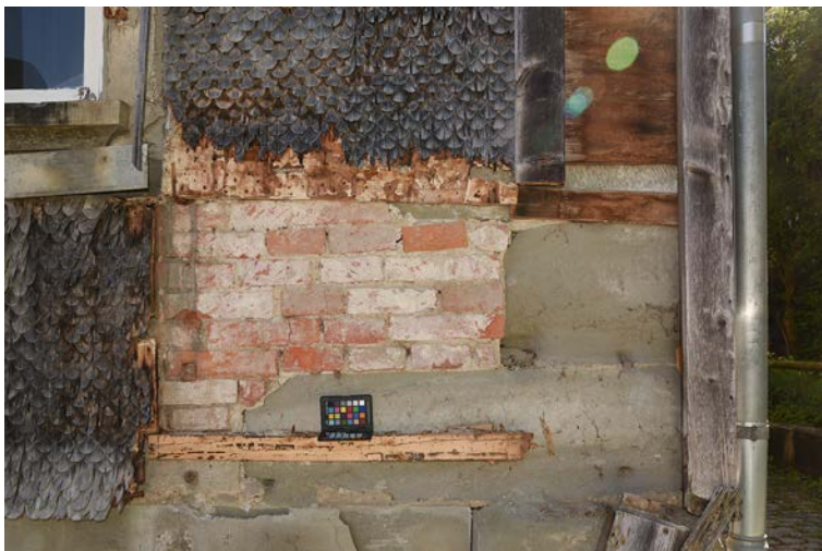
Abb. 11: Sondage an der Westfassade, rechte (südliche) Ecke. Auf dem Backsteinmauerwerk ist eine Holzlattung angebracht, auf welcher die Schindeln befestigt wurden. Zur besseren Abdichtung wurden sie mit Papierbögen (Abb. 13, Abb. 14) unterlegt.
