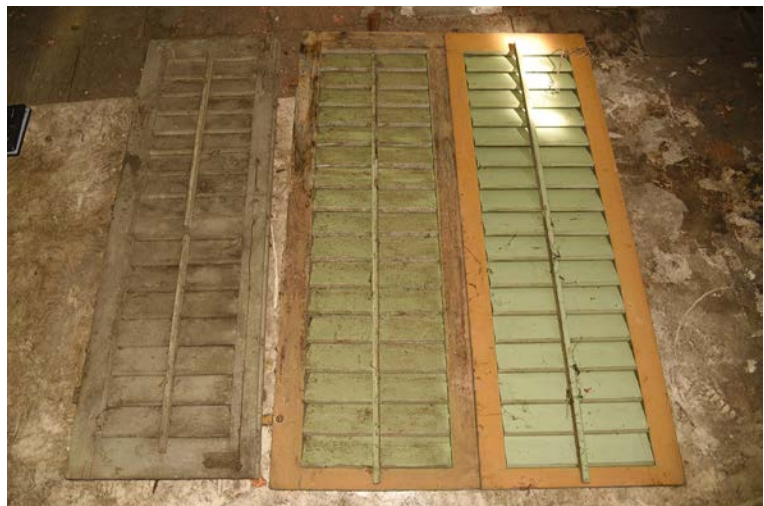
Abb. 23: Rechts doppelter Fensterladen, der im Estrich aufbewahrt wird. Er zeigt den zweifarbigen Anstrich, welcher der Phase 4 zugeordnet wird. Links ein jüngerer (?) Laden.
