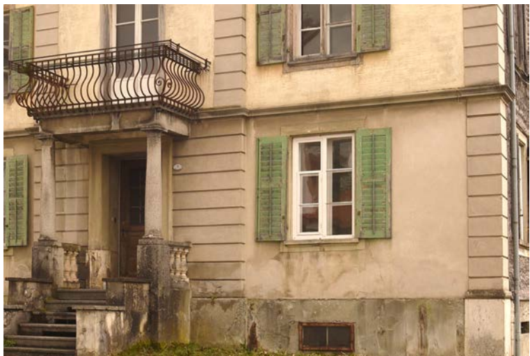
Abb. 28: Die Fassadengestaltung der Phase 5 zeigt aufgemörtelte Lisenen, einen materialsichtigen Putz im EG und einen «Krätzliputz» in den Obergeschossen.
