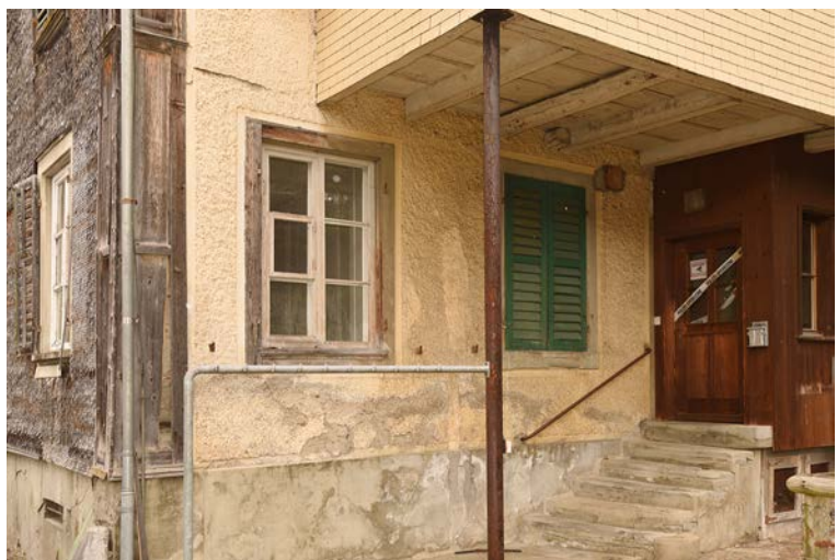
Abb. 6: Südwestliche Ecke. Links Schindelrand, rechts Besenwurf-Verputz, dazwischen Eckklisene aus Holz. Linkes Fenster der Südfassade mit Holzeinfassung, rechtes Fenster mit Sandsteingewände.
