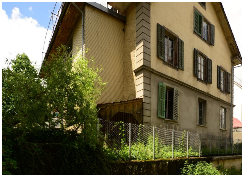
Verputzte Südseite mit Wormserputz und möglichen älterem Kalkgrundputz.
