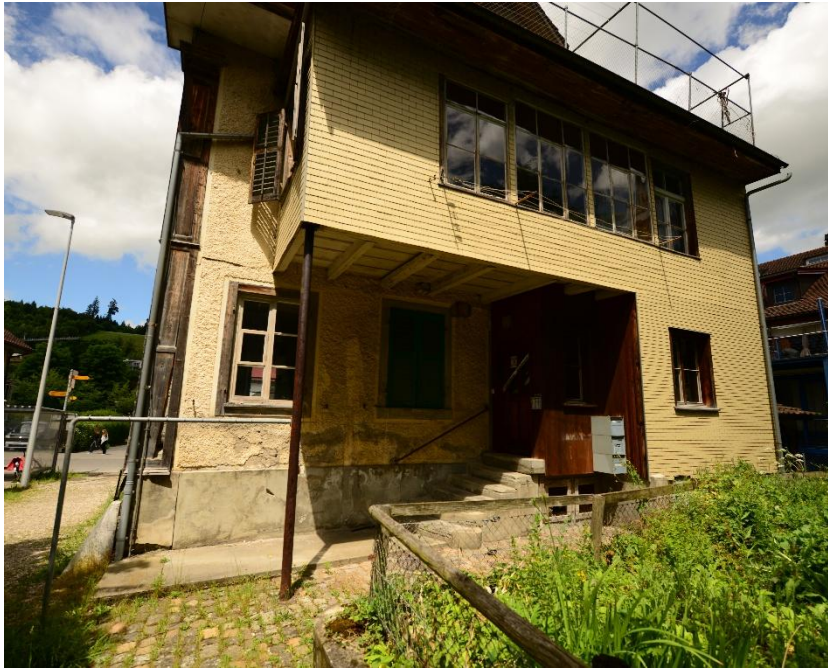
Südfassade Holz Anbau mit Holzisenen
