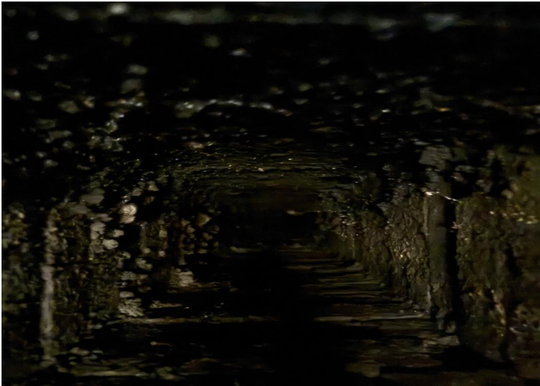
Innenansicht des beschädigten Kaminzuges mit Feuchtigkeitsspuren.
