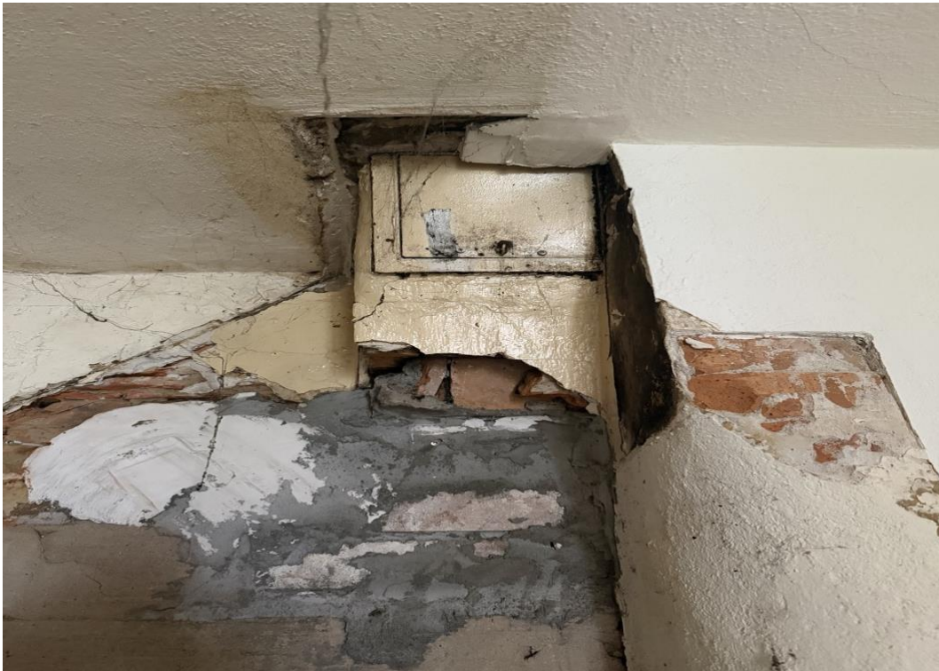
Teilweise entfernte bzw. verschlossene Feuerstelle in der Küche.
