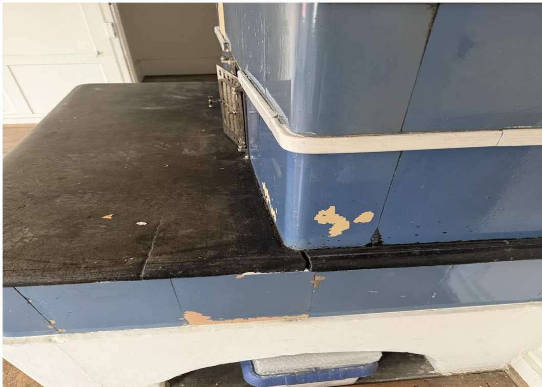
Beschädigte und abblätternde Kacheloberflächen am Ofen.
