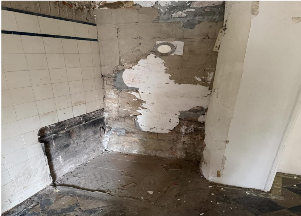
Umbau- und Verschlussarbeiten im Bereich der ehemaligen Feuerstelle.
