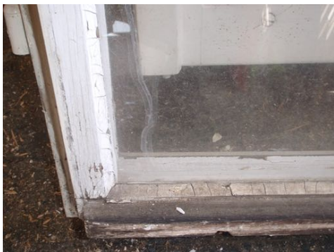
Fensterkitt Holzrahmen doppelverglast, Suva
