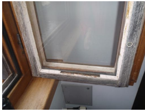
Fensterkitt mit Asbest. Auch wenn sich dieser löst, stellt er keine Gefahr für die Gesundheit der Anwohner dar.
