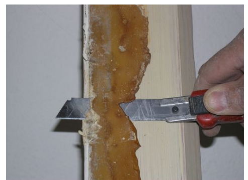
Anschlagkitt entfernen, Suva
