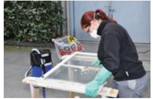
Entfernung eines asbesthaltigen Kitts mit Handwerkzeugen, Suva
