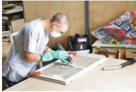
Entfernung eines asbesthaltigen Kitts, wärmebasiertes Verfahren, Suva
