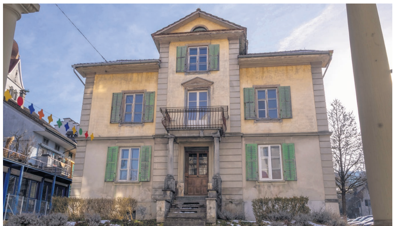
Hat eine neue Besitzerin erhalten: das Wohnhaus Zehntenplatz 3 mit Baujahr 1870.
